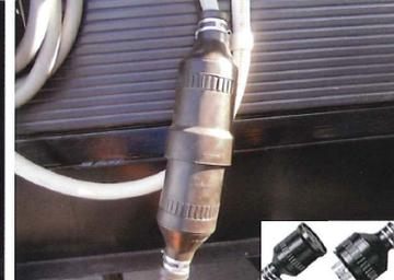
電気配線が工具なしで着脱可
