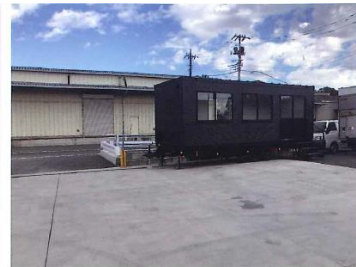
進行方向に固定の障害物なし
