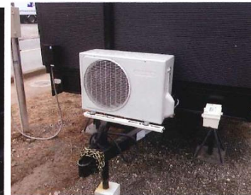
室外機が積載されている
