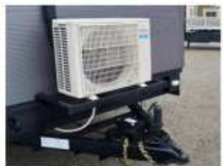
⑪エアコン等の室外機がトレーラーハウ스에積載されていること。
