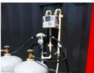
⑨ガスボンベがトレーラーハウ스에積載されているかまたはレンチのみで簡易に着脱できること。
