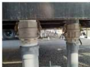
⑦排水管の接続方法が工具無しで着脱出来る方式であること。
