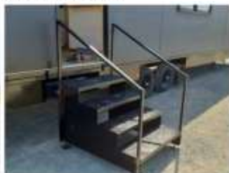
⑤「階段・デッキ」が独立した構造体であり、トレーラーハウスの移動に支障がない規模・
